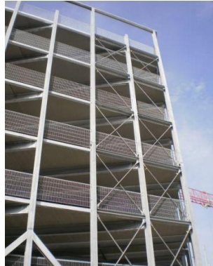
Contreventement sur un immeuble suisse, source [9]
