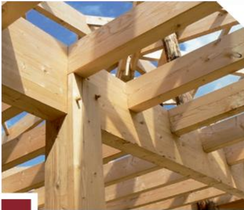
Poutre, poteau et solivage à queue d'aronde
